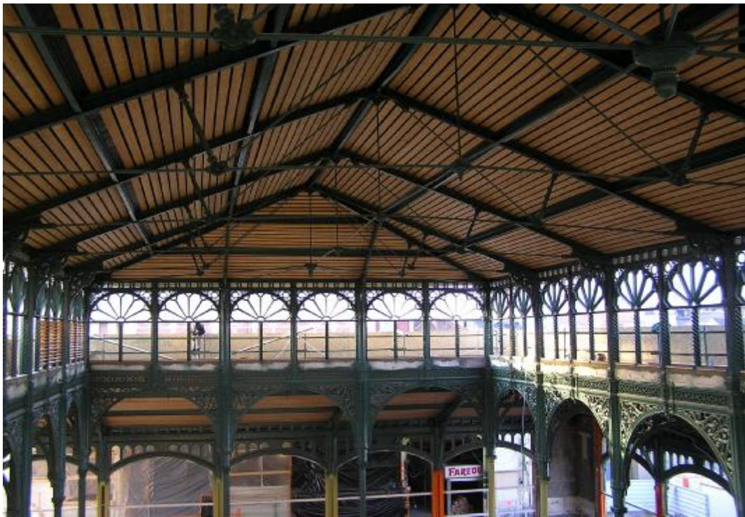
Habillage intérieur, sous face de couverture
