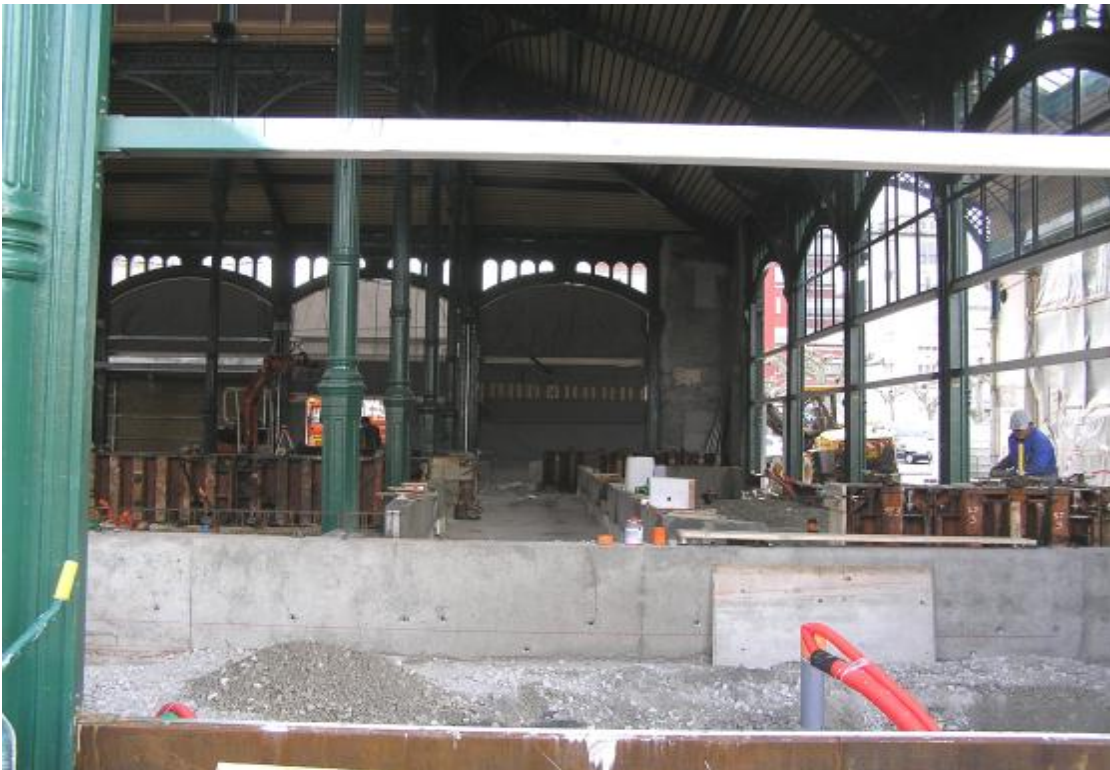
Construction des murets de séparation d'étals
