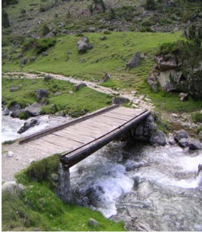
Pont de Pouey Caut
