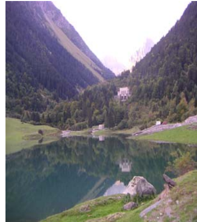
Le barrage du Tech
