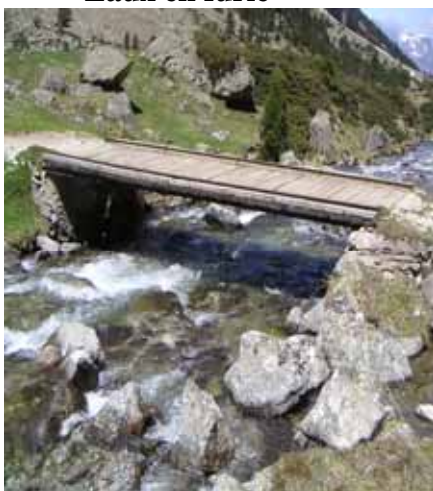
Pont de Pouey Caut
