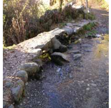
Pont sur l'Oulet
