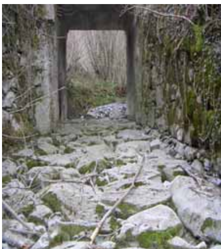
Lit asséché du Boustu
